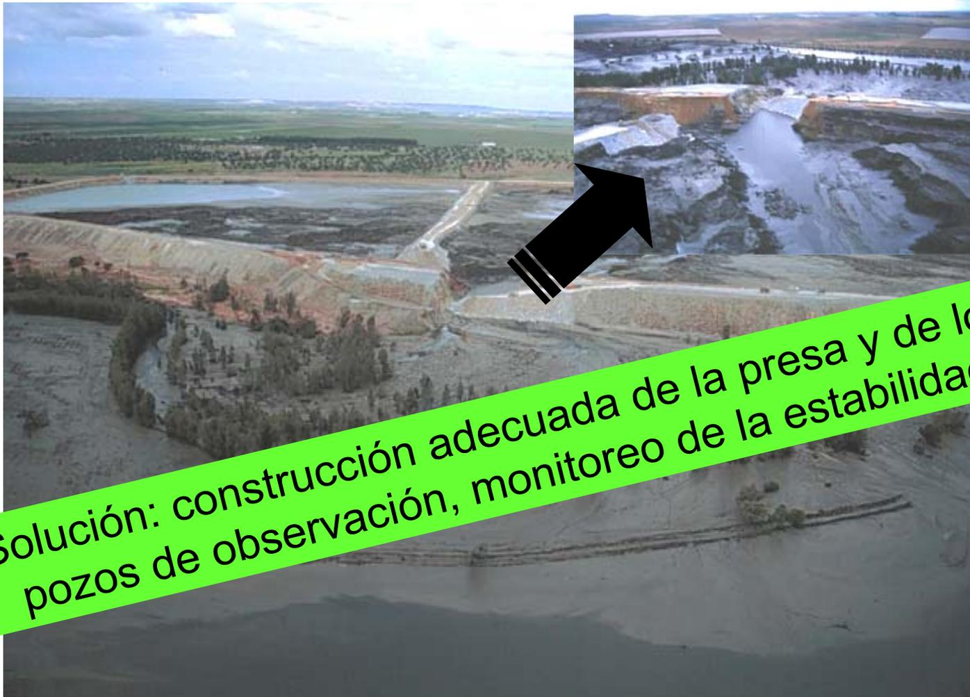
Solución: construcción adecuada de la presa y de los pozos de observación, monitoreo de la estabilidad.
