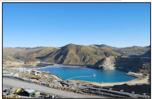
Presa de Relaves: No se emite ninguna descarga al Río Tingo
